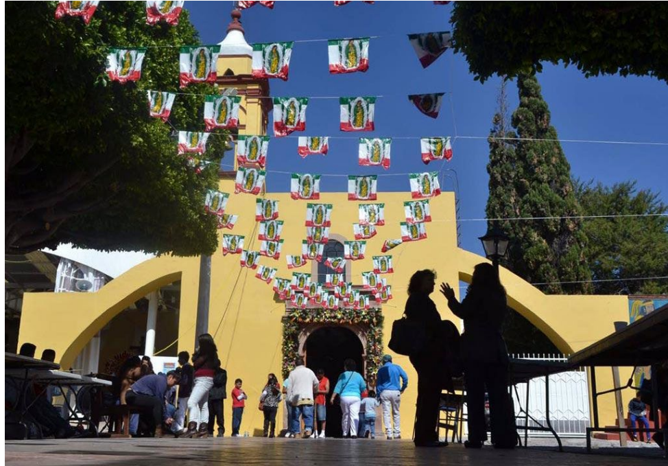
Figura 56 Templo de Tierras Negras, Barrio de Tierras Negras
